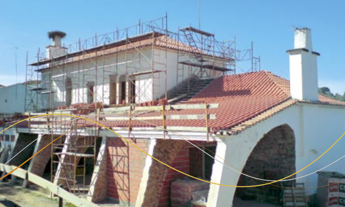
Obra do novo Centro de Saúde de Barrancos
