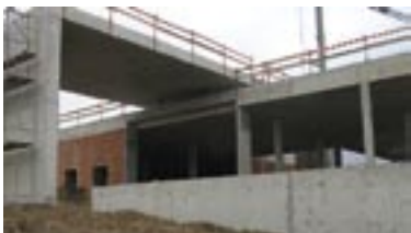
Aspecto da construção no novo CS Redondo
