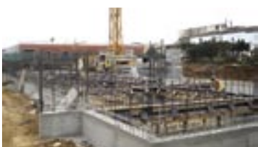
Início da obra no novo CS Vila Viçosa
