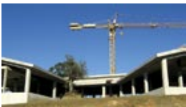
Fase da construção do novo CS Arraiolos
