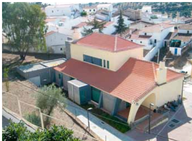
Centro de Saúde de Barrancos - vista das traseiras
