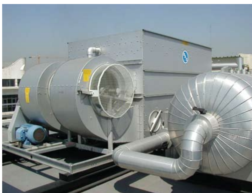
Figura 3: Condensador evaporativo
